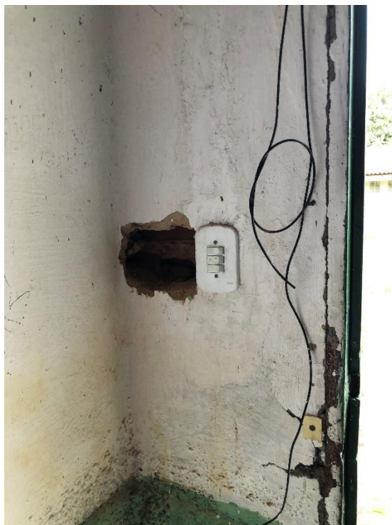
Foto 08: fiação elétrica exposta.
