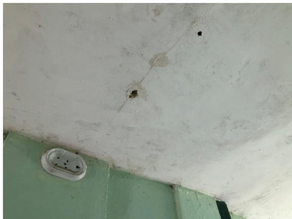
Foto 17: laje com infiltrações, iluminação externa precária.
