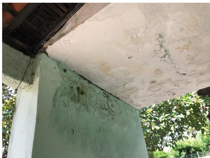
Foto 04: laje com infiltrações.
