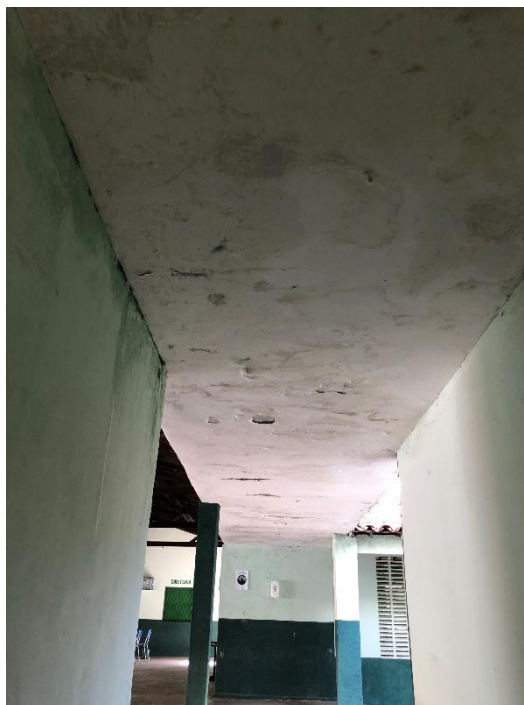
Foto 05: laje com infiltrações.
