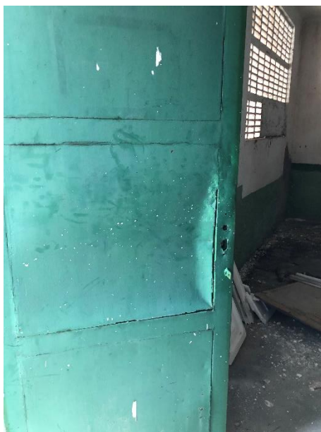
Foto 09: esquadrias danificadas, sem fechadura.
