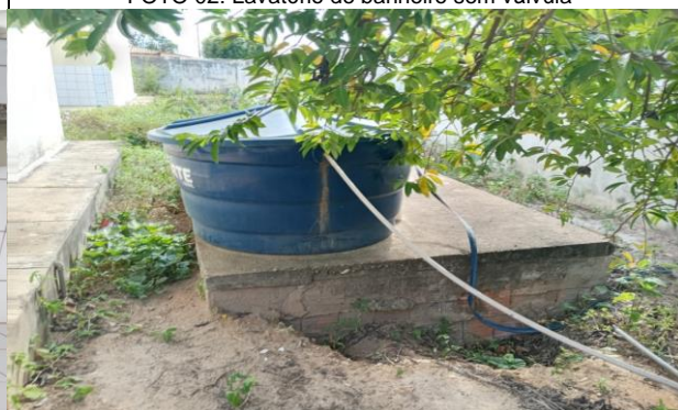
FOTO 04: Caixa d'água no chão, eleva-lá para ganhar pressão
