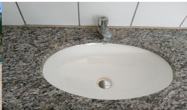
FOTO 02: Lavatório de banheiro sem válvula
