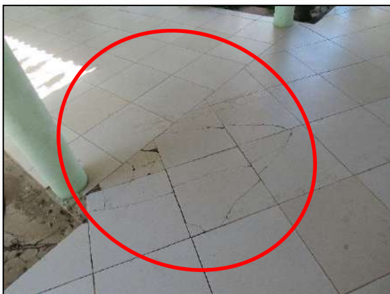
Imagem 10 – Trincas no revestimento cerâmico do piso nas áreas comuns dos blocos
