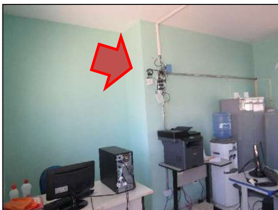
Imagem 08 e 09– Instalações elétricas precárias, expostas e tomadas fora do padrão
