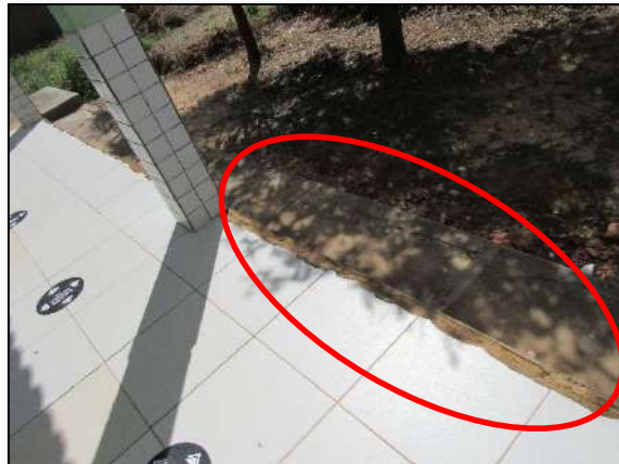
Imagem 10 – Trincas no revestimento cerâmico do piso nas áreas comuns dos blocos
