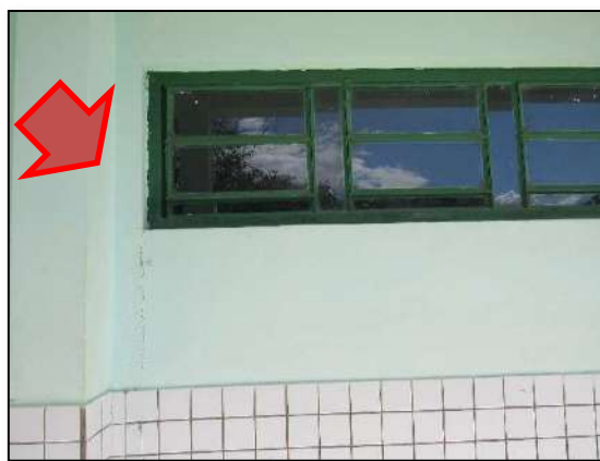
Imagem 02 – Fissuras inclinadas – ilustração Fonte: Thomaz 2000
