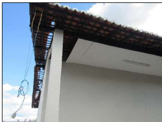
Imagem 12 e 13 – Pontos necessários para retelhamento
