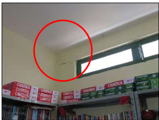
Imagem 02 – Fissuras inclinadas – ilustração Fonte: Thomaz 2000
