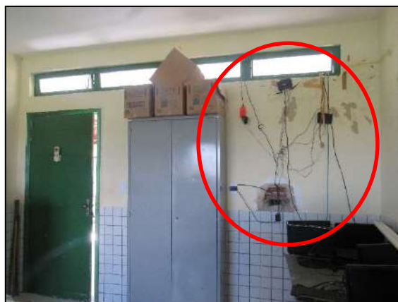
Imagem 08 e 09– Instalações elétricas precárias, expostas e tomadas fora do padrão
