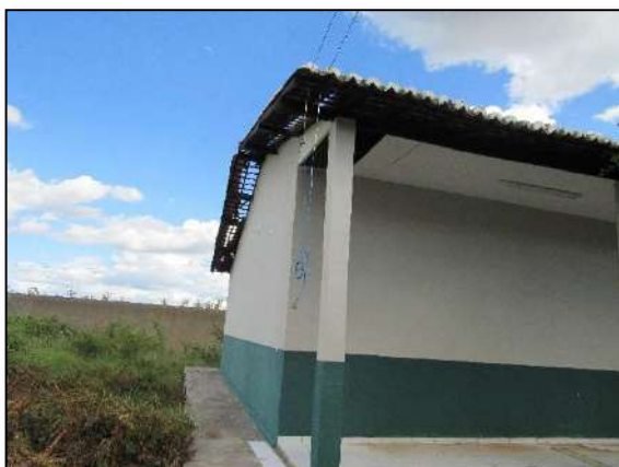
Imagem 12 e 13 – Pontos necessários para retelhamento
