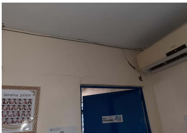
Superior de porta e inferior da laje na administração com rachaduras
