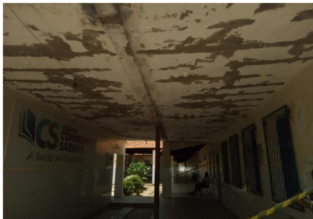
Vista inferior da laje de entrada apresentando sinais de infiltração.
