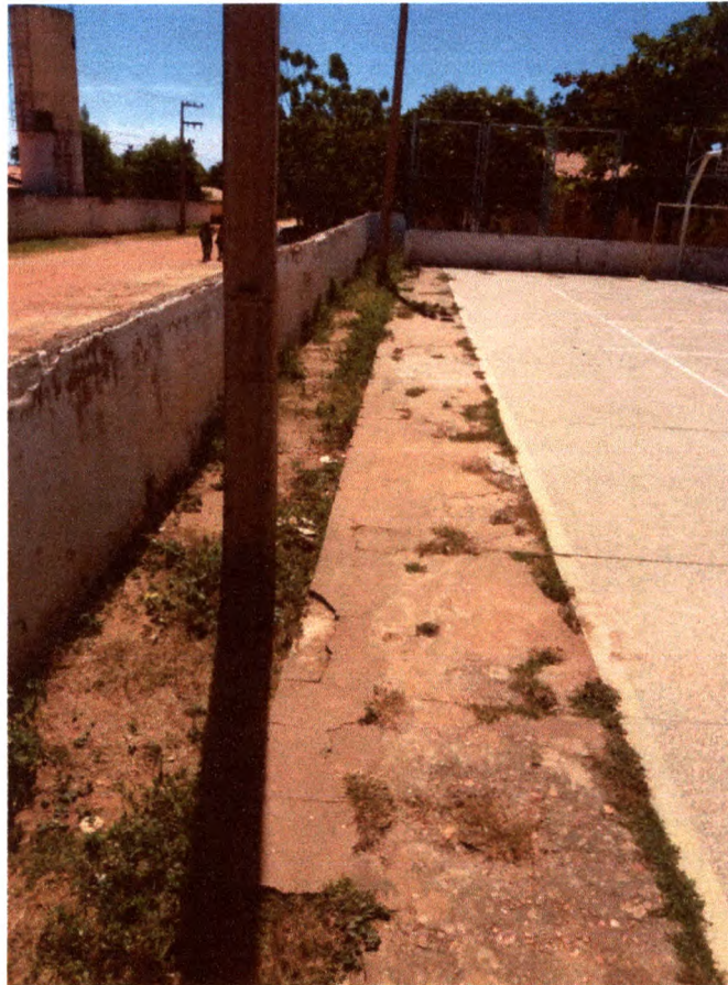
Figura 5 – Irregularidade em piso e Necessidade de Ampliação de Alamedado
