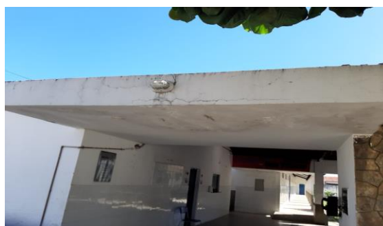
FOTO 02: Colocar manta asfáltica em todas as maquises expostas as intempéries da escola
