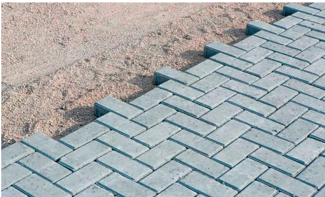
Figura 3 - Detalhe do piso intertravado
