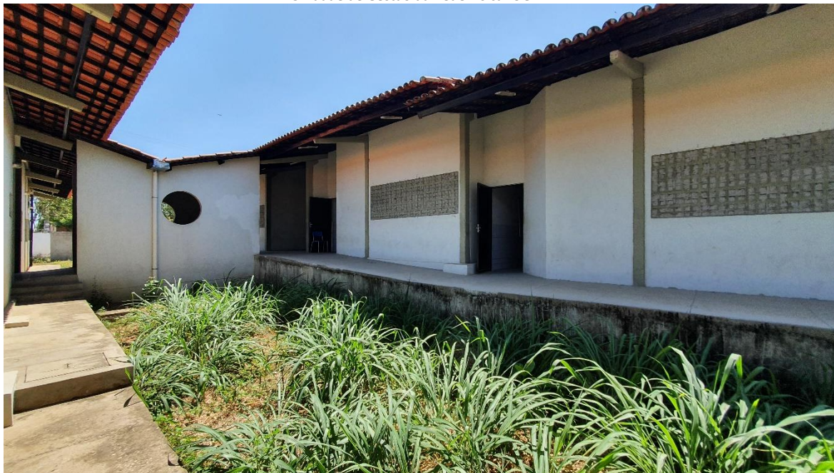
Figura 7 Detalhe da diferença de nível entre blocos e área de jardim, sem devida proteção(guarda-corpo).
