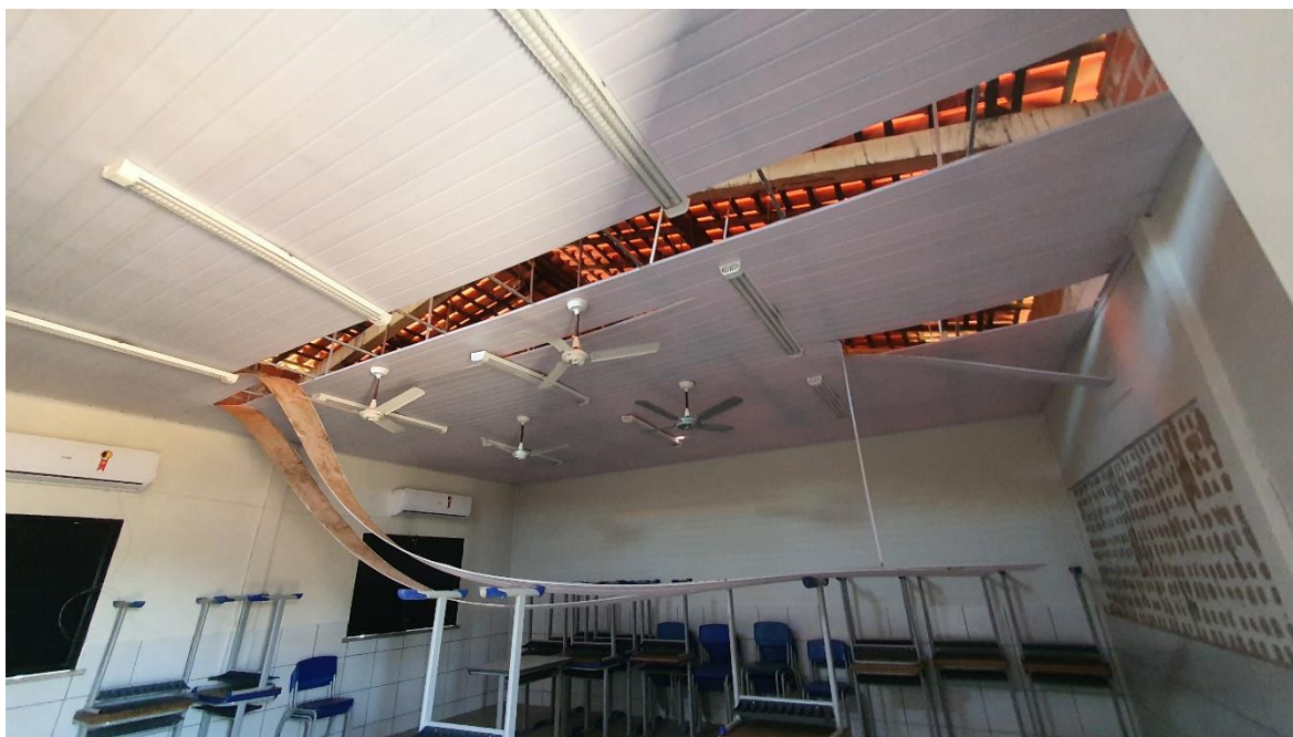
Figura 22 Detalhe de sala de aula com forro danificado
