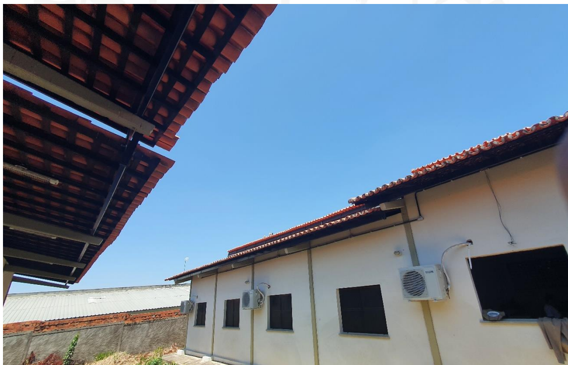
Figura 21 Detalhe da diferença entre telhados por onde pombos acessam o vão do forro
