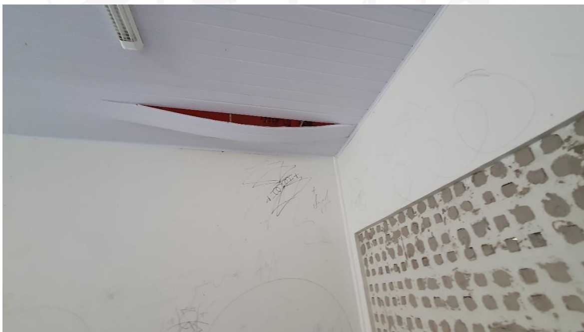
Figura 15 Detalhe de sala de aula com forro de PVC a ser revisado e paredes a receber limpeza e pintura
