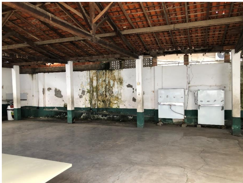
Foto 14 – Telhado do recreio com telhas quebradas, madeira muito danificada pela ação de intempéries e cupins. Instalações elétricas e hidráulicas inadequadas.
