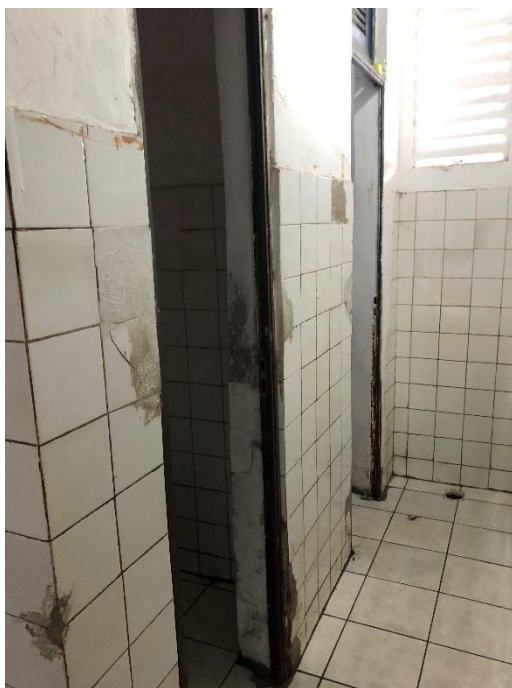
Foto 09 – Banheiro, com louças, peças sanitárias, piso, revestimento e esquadrias danificados.
