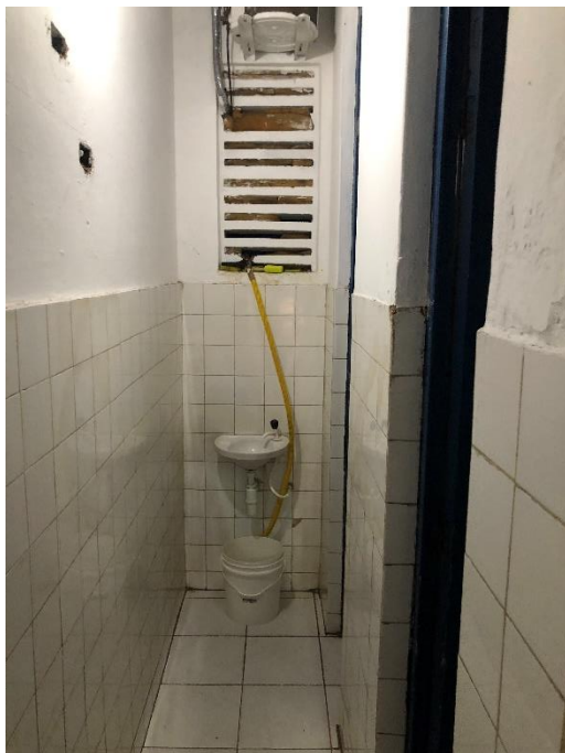
Foto 08 – Banheiro, com louças, peças sanitárias, piso, revestimento e esquadrias danificados.
