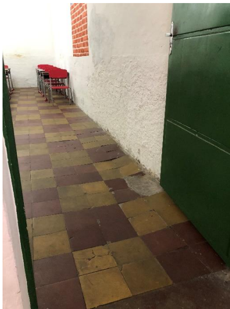
Foto 12 - Salas de aula com iluminação inadequada, pintura deteriorada, piso apresentando afundamento.
