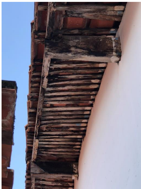
Foto 18 – Telhado do recreio com telhas quebradas, madeira muito danificada pela ação de intempéries e cupins. Instalações elétricas e hidráulicas inadequadas.
