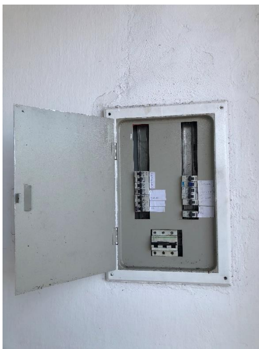
Foto 03 – quadro de distribuição de energia.
