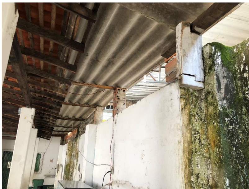
Foto 17 – Telhado do recreio com telhas quebradas, madeira muito danificada pela ação de intempéries e cupins. Instalações elétricas e hidráulicas inadequadas.
