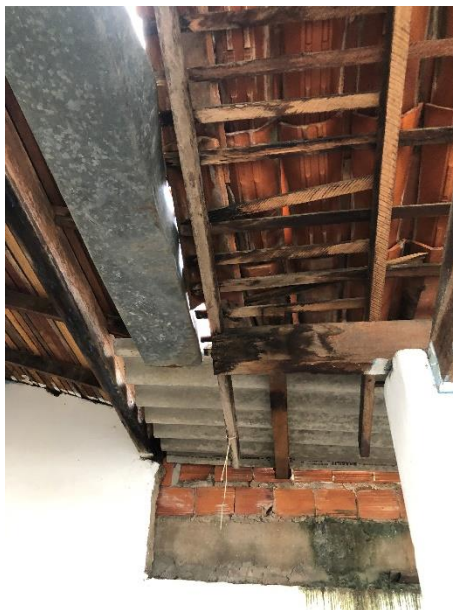
Foto 16 – Telhado do recreio com telhas quebradas, madeira muito danificada pela ação de intempéries e cupins. Instalações elétricas e hidráulicas inadequadas.
