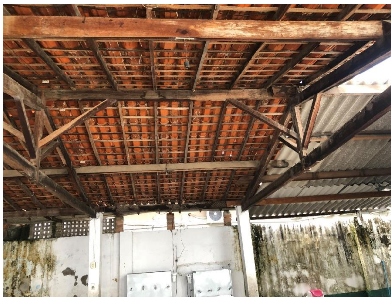
Foto 15 – Telhado do recreio com telhas quebradas, madeira muito danificada pela ação de intempéries e cupins. Instalações elétricas e hidráulicas inadequadas.
