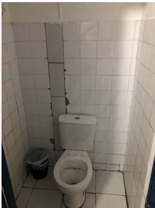
Foto 10 – Banheiro, com louças, peças sanitárias, piso, revestimento e esquadrias danificados.
